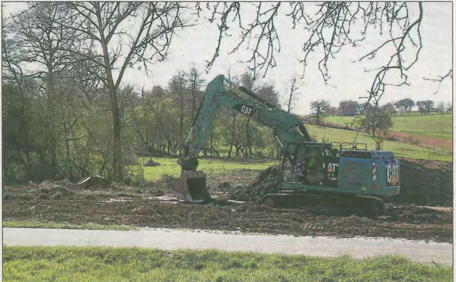
Der Bagger ist bereits fleißig an der Arbeit: An der Kreisstraße in Richtung Gauangelloch wird das Hochwasserrückhaltebecken Schatthausen errichtet. Mit seiner Fertigstellung im kommenden Jahr soll der Ort dann vor einem hundertjährigen Hochwasser geschützt werden.
