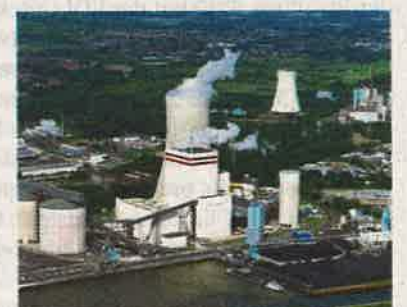
Verlustbringer: Das Steinkohlenkraftwerk Lünen bereitet den Eigentümern, der Aachener Trianel, große Sorgen. Foto: Trianel
