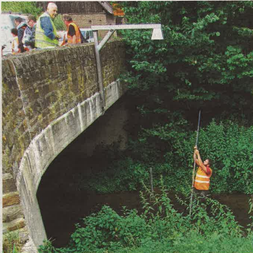
Justierung: Vor der Inbetriebnahme der Messanlage wird der Abstand zur Wasseroberfläche und zur Bachsohle mit den Laufzeiten der Radarimpulse abgeglichen. Foto: Ines Gollnick
