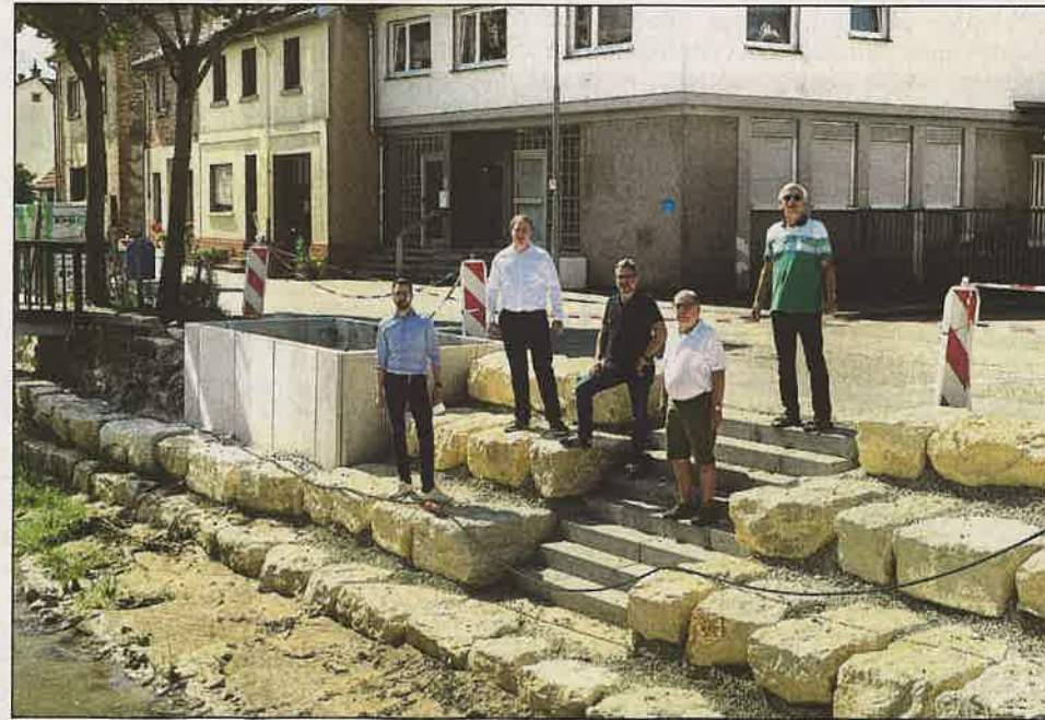
CDU-Bundestagskandidat Moritz Oppelt (l.) schaute sich mit Vertretern der CDU-Baiertal den Baufortschritt zum hochwassersicheren Ausbau des Gauangelbachs an. Foto: köpa
