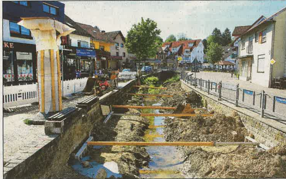
In Baiertal wird derzeit der Gauangelbach für ein mögliches 100-jährliches Hochwasser ausgebaut. Foto: Helmut Pfeifer
