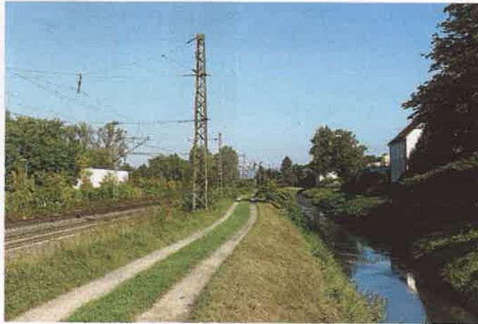
Entlang der Bahnlinie wird sich der Ausbau des Leimbachs schwierig gestalten – zu wenig Platz Foto: sd
