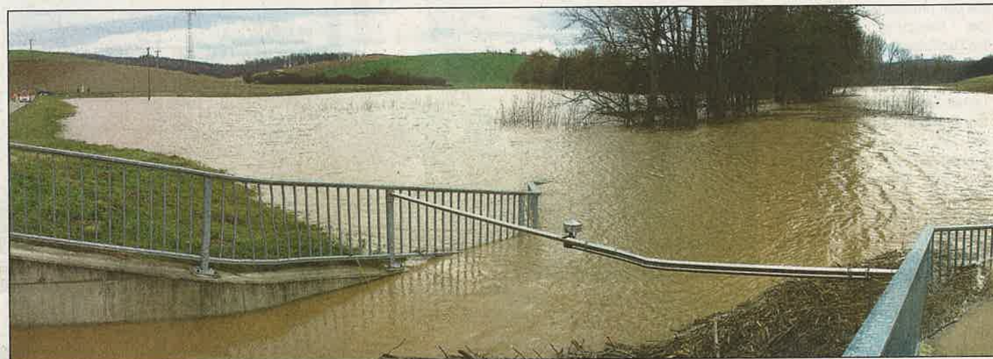
Verhinderte 2008 ein schlimmeres Hochwasser: das randvoll gelaufene Rückhaltebecken des Lobbachs bei Mönchzell. Fotos: privat
