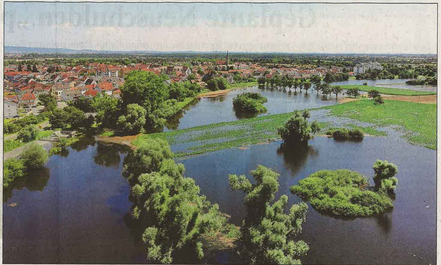
Der Sommerdamm auf den Schwetzingen Wiesen bei Brühl ist erneut gebrochen, das Gelände überflutet worden. Foto: FFW
