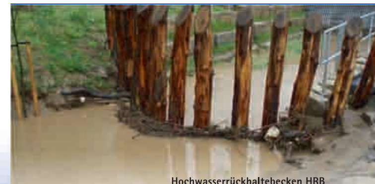
Hochwasserrückhaltebecken HRB Dielheim-Baiertal 2007 Hohenhardter Hof 2009 Dielheim-Untershof 2009 Gauangelloch 2010 Maisbachtal 2011
