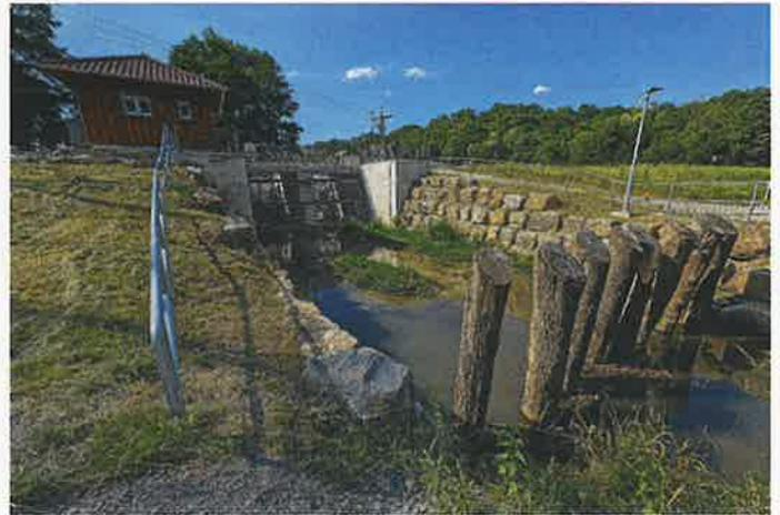
Das neue Rückhaltebecken im Naturschutzgebiet Altwiesloch kann bis zu 53.000 Kubikmeter Wasser aufnehmen – für mehr Sicherheit bei Starkregen.
