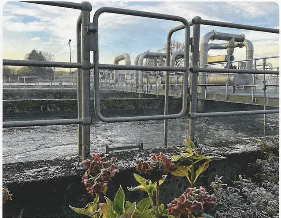
Die Kläranlage Wiesloch wird um eine vierte Reinigungsstufe erweitert, um Spurenstoffe aus dem Abwasser noch wirkungsvoller zu entfernen. Foto: AHW
