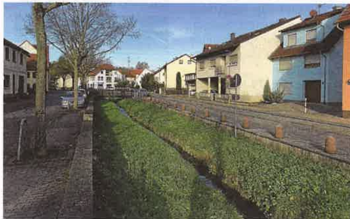
Vor zwei Jahren trat der Gauangelbach in der Baiertaler Ortsmitte über die Ufer und verursachte erhebliche Schäden bei privaten und gewerblichen Anliegern. Foto: stadt
