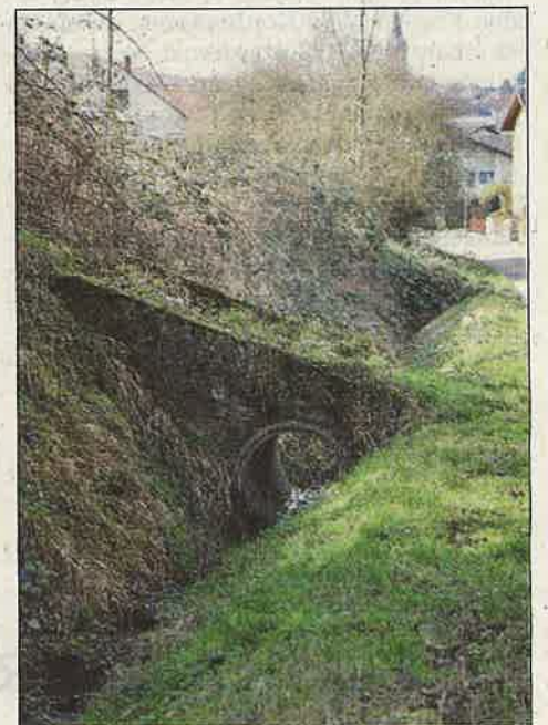
Die alte Stauanlage an der Käsklinge (rechts) ist nicht mehr betriebssicher, der Damm könnte brechen. Das Problem soll nun so schnell wie möglich behoben werden. Dazu gehört auch die Beseitigung der Verdolungen am Käsklingengraben (links). Fotos: Pfeifer
