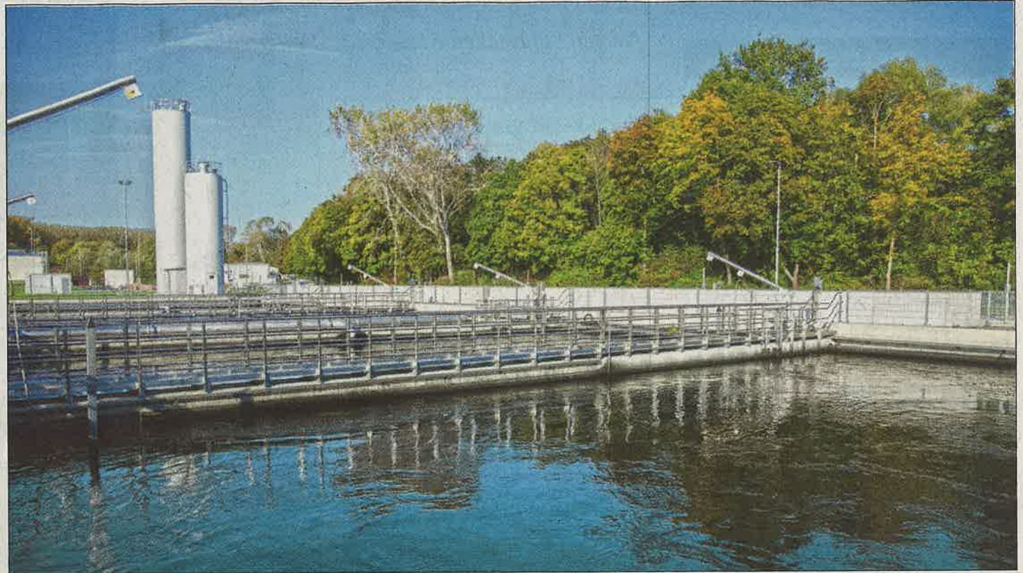
Nur wenige Klärwerke in Deutschland haben sie: Pulveraktivkohleanlage im Mannheimer Klärwerk. Foto: Schumann
